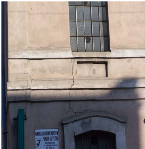
Widok pasa międzyokiennego
