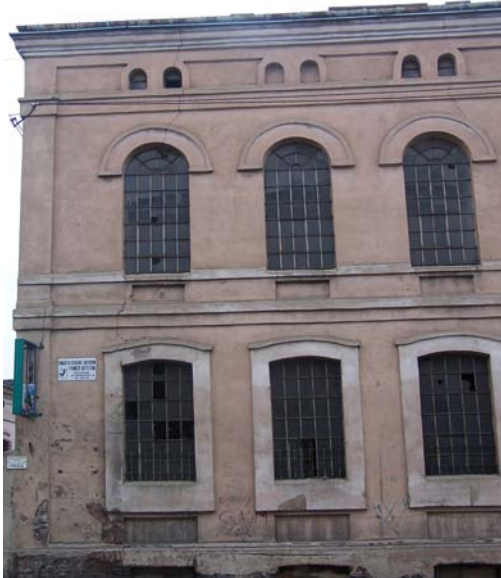
Widok lewej strony elewacji
