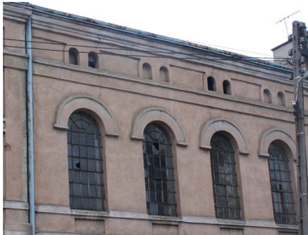
Widok prawej strony elewacji
